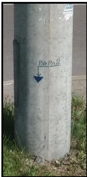
Рис.1 - Вид вынесенного временного высотного репера
